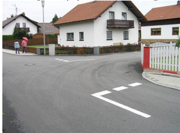
63. számú ábra A megállás helyét jelző vonal (Németország)
